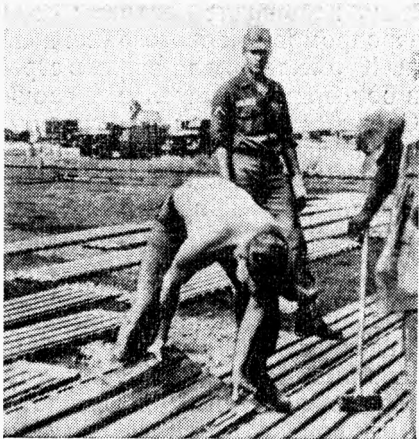
Рис. 1. Укладка сборно-разборного покрытия типа М8А1.
