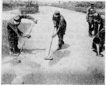
Рис. 3. Общий вид ВПП с эластичным покрытием типа Т-17 (на переднем плане — нанесение специальной мастики для увеличения сцепления поверхности покрытия с колесами шасси самолета).
